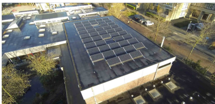
Van der Waalslaan 33, 40 panelen, gerealiseerd maart 2014
