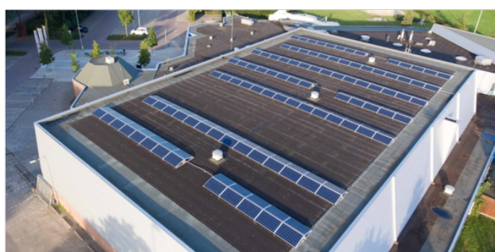
Sportparklaan 16, 192 panelen, gerealiseerd mei 2015
