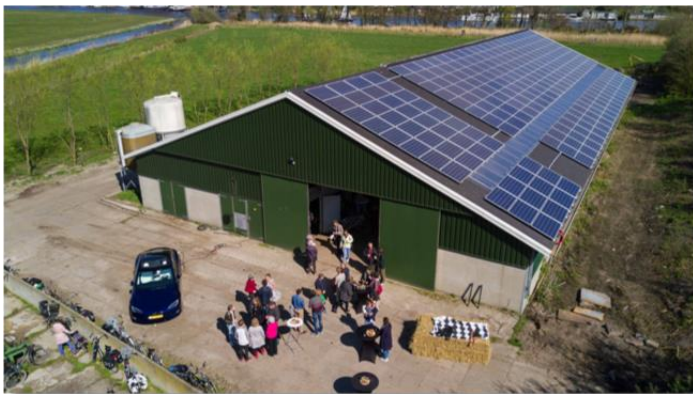
Cruquiusweg 45 (Dinkelhoeve), 272 panelen, gerealiseerd april 2017
