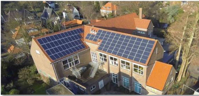
Overboslaan 28, 109 panelen, gerealiseerd april 2014
