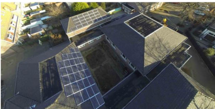
Bosboom Toussaintlaan 18, 54 panelen, gerealiseerd april 2014
