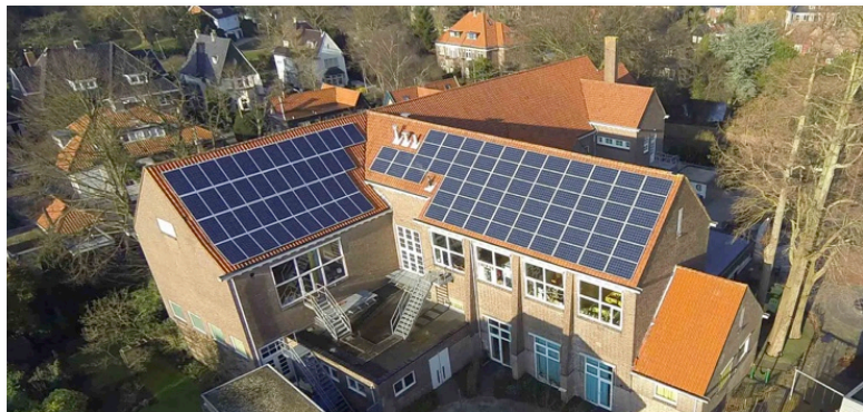
Overboslaan, 109 panelen, april 2014
